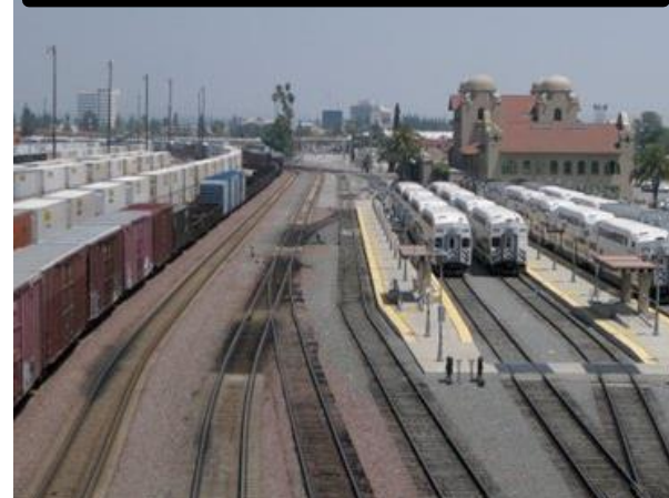
Móviles que no están en la carretera
